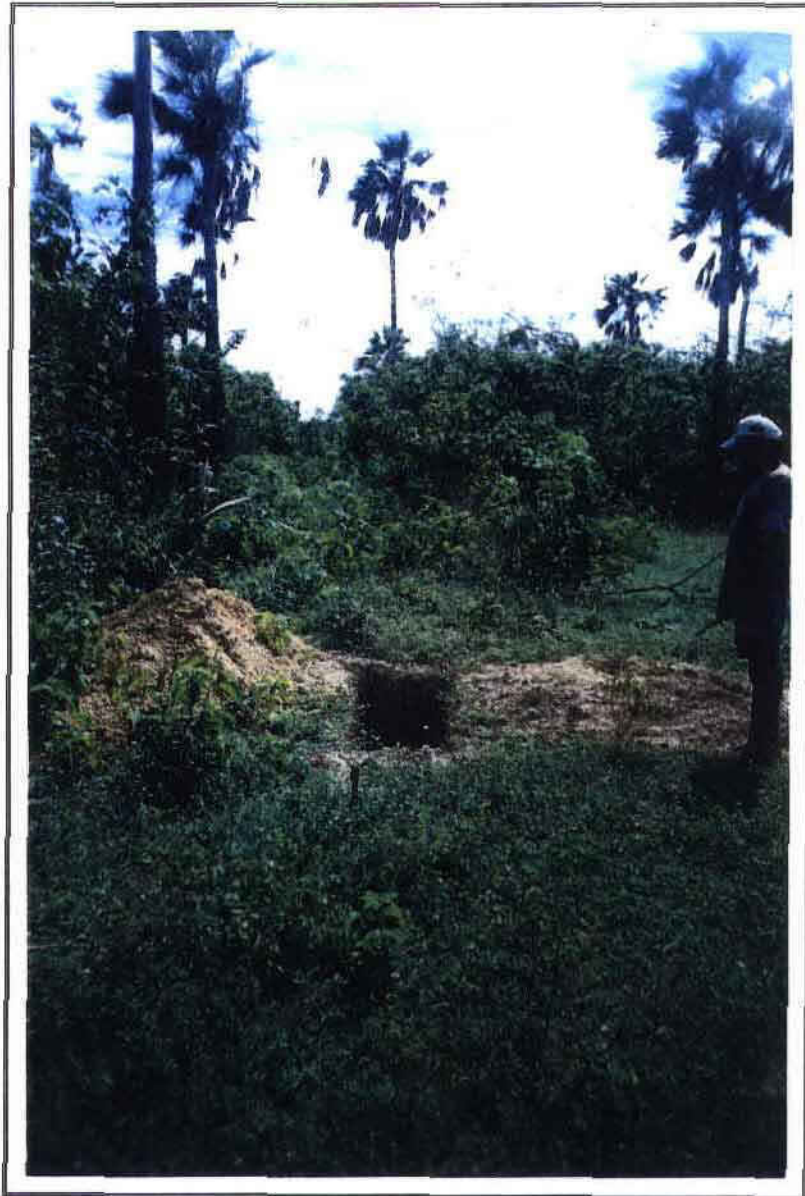
Foto 13 – Furo na estaca 71 no eixo da barragem.
