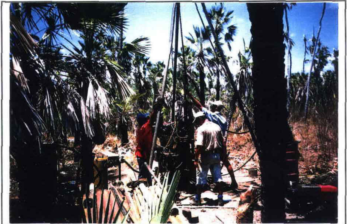
Foto 01 – Execução das Sondagens – SM-06.
